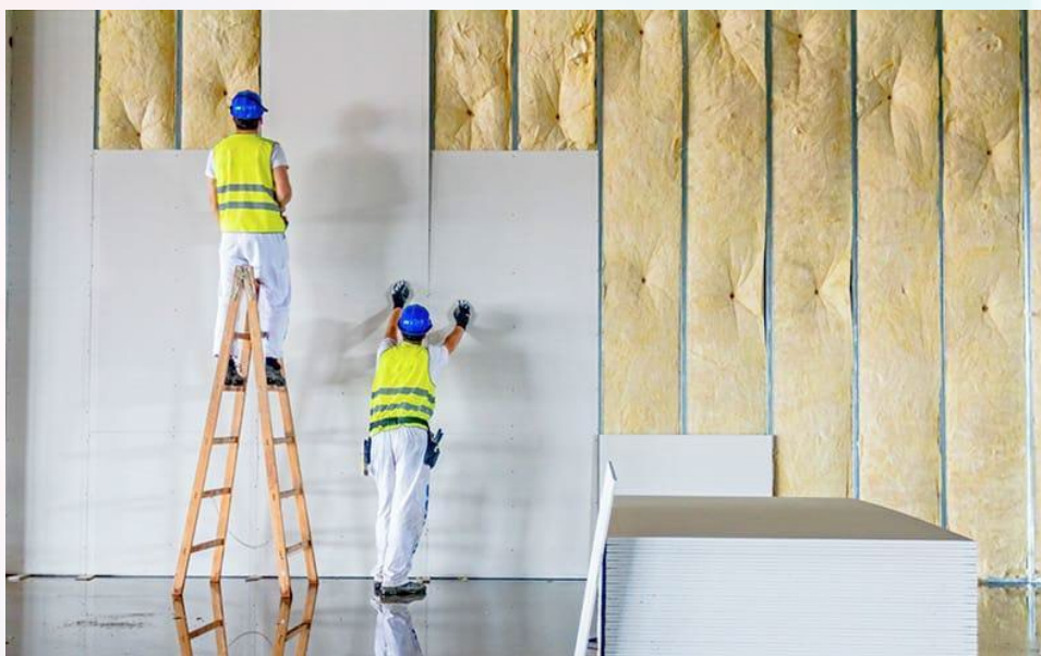
Figura 1 – Instalação do drywall.
