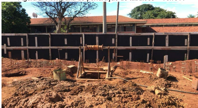
Figura 2: Fotografia de perfuração de tubulões – Torre A
