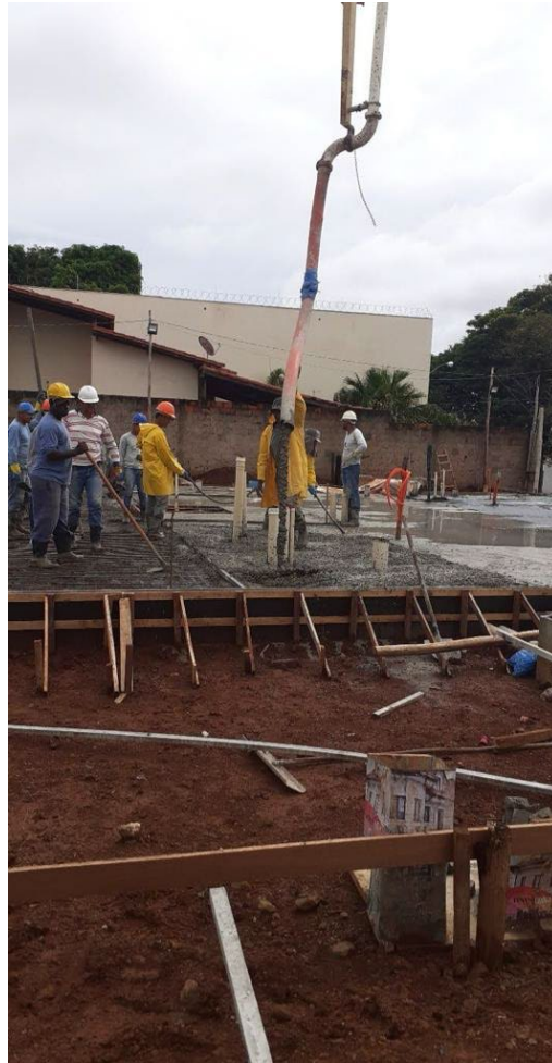
Figura 3: Fotografia de concretagem radier – Torre A
