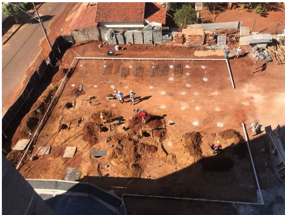
Figura 4: Fotografia de perfuração de tubulões - Torre B
